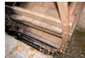
La roue (à l'origine à aube, aujourd'hui à godet) d'un diamètre de cinq mètres entraînait par engrenage quatre meules de silex situées au second niveau du moulin, à raison de cent tours minute. Toute l'architecture est pensée pour limiter les manutentions excessives de charge. C'était un savant réseau de poulies et de transmissions pour le déplacement des meules, l'alimentation en blé ou le rangement des sacs de farine.
