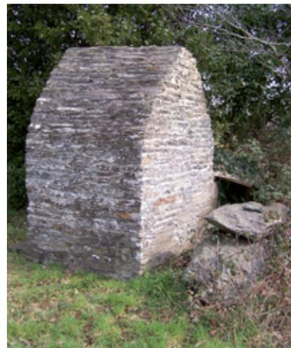
Le couverture est en encorbellement. Les pierres sont montées les unes sur les autres avec un léger décalage à chaque assise jusqu'à se rejoindre et fermer le passage.
