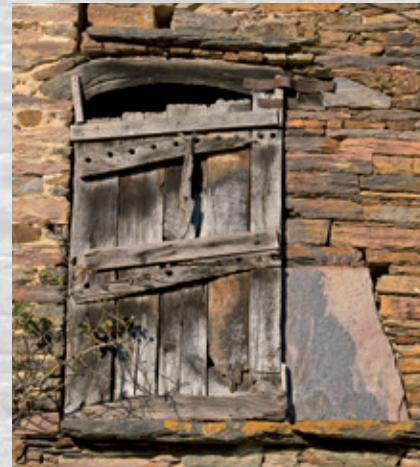
Ci-contre, remploi à contre-sens d'une ancienne porte à lames, on distingue les traverses, les chevilles de bois et le chardonnet\* placé, ici, dans un anneau de fer.
