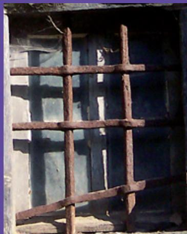
Pour les grilles les plus anciennes, le réticule\* est formé de trous renflés aux passages des barres comme ici à Bocadoève. C'était une façon de décourager le sciage des grilles.
