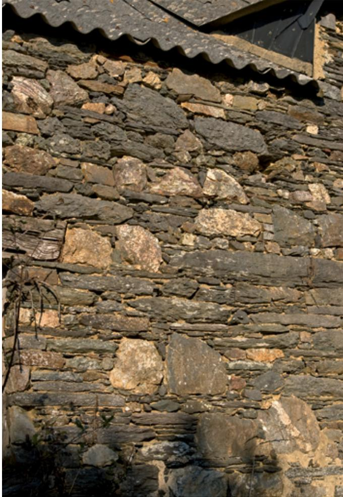
Au Rocher ci-dessus, de grosses pierres de quartz ont été dispersées dans la maçonnerie plutôt qu'agencées en assises. Probablement dans un souci de solidité et éventuellement dans l'inclination à vouloir se garder du mauvais esprit. On pense que les belions, ainsi répartis, assurent une protection.
