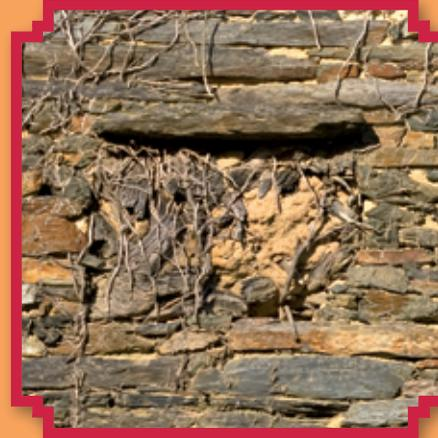
Conditionnés par les vents dominants et le sens de la pluie, les abouts de poutres sont légèrement en retrait pour les murs exposés au sud et au nu du mur pour les parties au nord. Souvent ils sont protégés par un larmier, cette pierre plate placée en saillie juste au-dessus.
